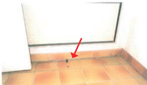
Affaissement du plancher mis en évidence par le décollement entre plinthes et dallage - Maison Jourdan.
